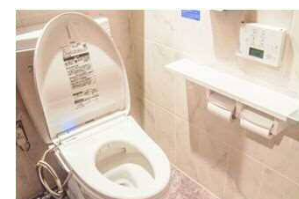
洋式化・温水洗浄便座の設置
