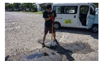
職員による小規模修繕 駐車場修繕【八部公園】
