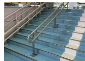
手摺りの設置
