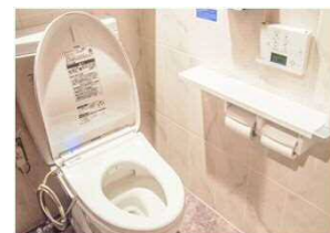
洋式・温水洗浄便座の設置
