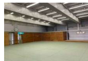
冷暖房設備の設置
